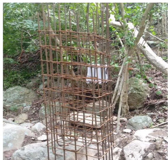
F-4 Acero de refuerzo pedestales k1-400
